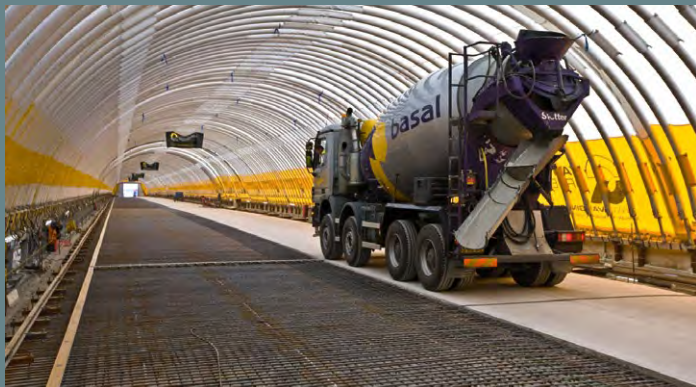
Betonnen overlaging ter versterking van de Hollandse Brug, foto: Dyckerhoff AG
