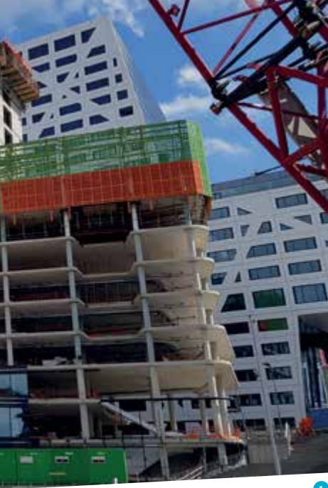
1 Het nieuwe WTC Utrecht in aanbouw, gezien vanuit de bouwput van parkeergarage Jaarbeursplein foto: Chris van der Ploeg, ABT
